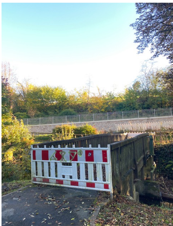
Hohe Kosten für kleine Baustelle...
